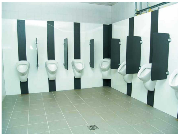
Foto: Beispielfoto nach Sanierung einer Urinalanlage mit Vorwandinstallation, Jungen WC
