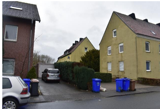
Abb. 7 Rückseite der Häuser Hawerkämpe 35 und 37
