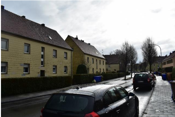
Abb. 4 Fassaden der Häuser Hawerkämpe 48, 46, 44, 42
